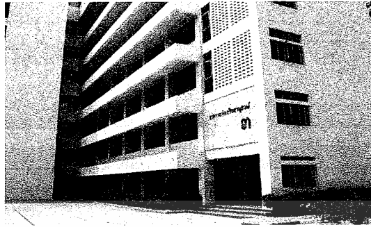
รูปที่ 3.3 แสดงสภาพแวดล้อมทางด้านทิศเหนือ
