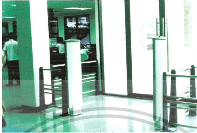
รูปที่ 2.72 เครื่องตรวจทางเข้าออกอาคาร Virtual Library
