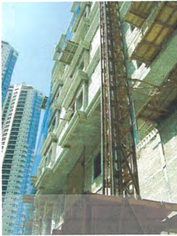
ภาพที่ 1.1 ลักษณะภาพถ่ายอาคารด้านทิศเหนือ
