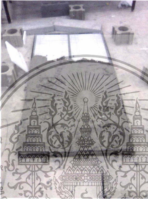
รูปที่ 3.9 แสดงการเทซีเมนต์มอร์ตาร์หล่อพื้นคอนกรีตเสริมเหล็ก
