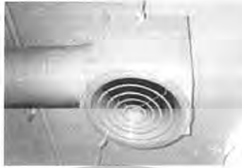
ภาพที่ 2.63 ภาพแสดงระบบปรับอากาศแบบ (CEILING DIFFUSER)
