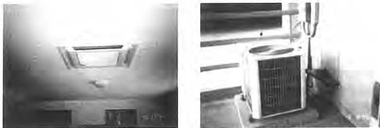
ภาพที่ 2.62 ภาพแสดงระบบปรับอากาศแบบ SPLIT TYPE
