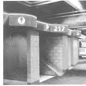
ภาพที่ 2.38 ป้ายที่ติดขึ้นจากผนัง
