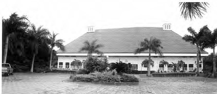
ภาพที่ 3.17 ภาพด้านอาคารทางทิศตะวันตก
