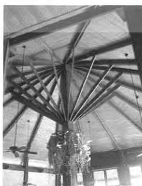
ภาพที่ 2.48 แสดงโครงหลังคา
