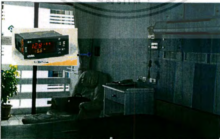
รูปที่ 3.6 การติดตั้งเทอร์โมสแตทแบบอิเล็กทรอนิกส์ห้องพักผู้ปวย
