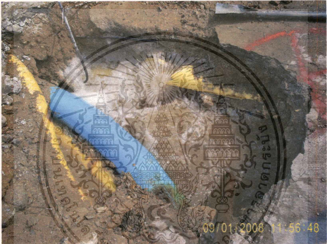
รูปที่ 5.8 แสดงภาพท่อ AC 300 mm. แดกเมื่อขุดพบ
