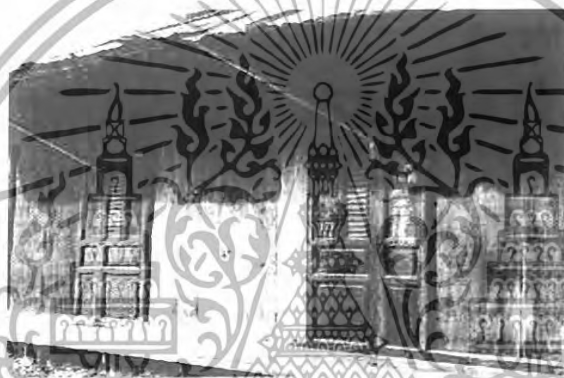
ภาพที่ 4.52 ฝาผนังแบบจีน เป็นการทำไม้เข้านัน และวางไม้เป็นเส้นตั้ง การเข้าตัวไม้จะแนบกันสนิทอยู่บริเวณคานตัวเมืองเก่าบางกะจะ จันทบุรี
