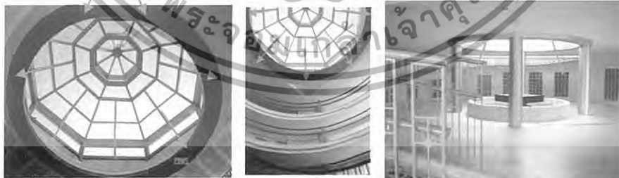
ภาพที่ 4.16 ตัวอย่างแสดงลักษณะการใช้แสงสว่างจากดวงอาทิตย์ภายนอกอาคาร จากหลังคาโดมกระจก นำมาใช้ในอาคาร และการเจาะ space โถงเชื่อมกันในแต่ละชั้นเพื่อให้แสงสว่างส่องถึงทั่วทุกชั้นจนถึงส่วน โถงลานน้ำพุดังกล่าว
