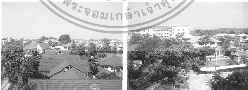
ภาพที่ 3.5 ทิศตะวันออก ติดกับอาคารบ้านพักอาศัย
