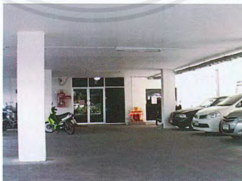
บริเวณลานจอดรถ
