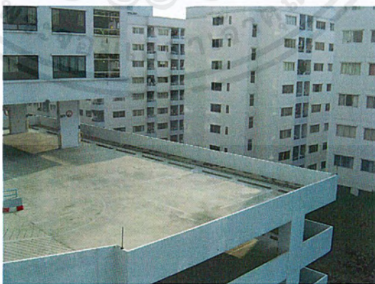
บริเวณลานจอดรถ
