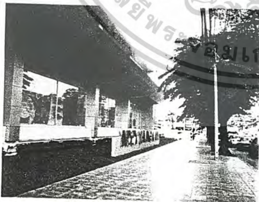
ภาพที่ 4.25 แสดงอาคาร Index Living Mall ซึ่งเป็นอาคารข้างเคียงของพื้นที่ตั้งโครงการ ( อยู่ฝั่งตรงข้ามที่ตั้งโครงการ )
