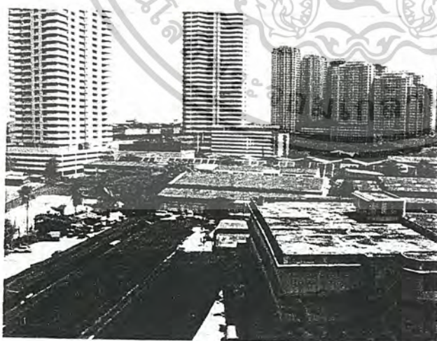
ภาพที่ 4.13 แสดงกลุ่มอาคาร เอส วี ซิตี้ ซึ่งเป็นอาคารข้างเคียงของพื้นที่ตั้งโครงการ
