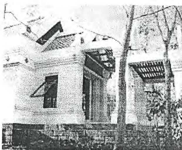
รูปที่ 2.3 อาคารศูนย์บริการข้อมูลพนมรุ้ง ปีกด้านตะวันออก
