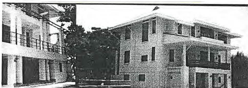
รูปที่ 2.7 แสดงรูปอาคาร
