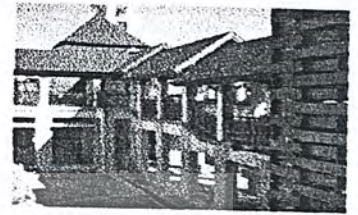
ทางเชื่อมระหว่างอาคาร 1 กับอาคาร 5 ที่มีการลดระดับมาเป็นขั้นๆ โดยทางเดินเป็นช่องโปร่งลมพัดผ่านได้สะดวก
