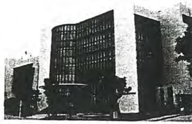
ภาพที่ 8.43 ทางเข้าอาคาร BIOTEC ซึ่งอยู่ด้านทิศตะวันตก
