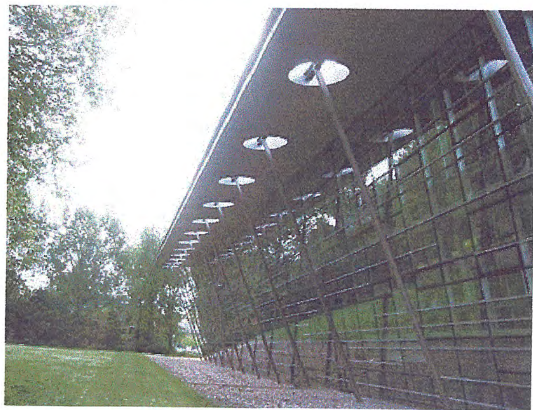
ผนังกระจก curtain wall ของห้องสมุด
