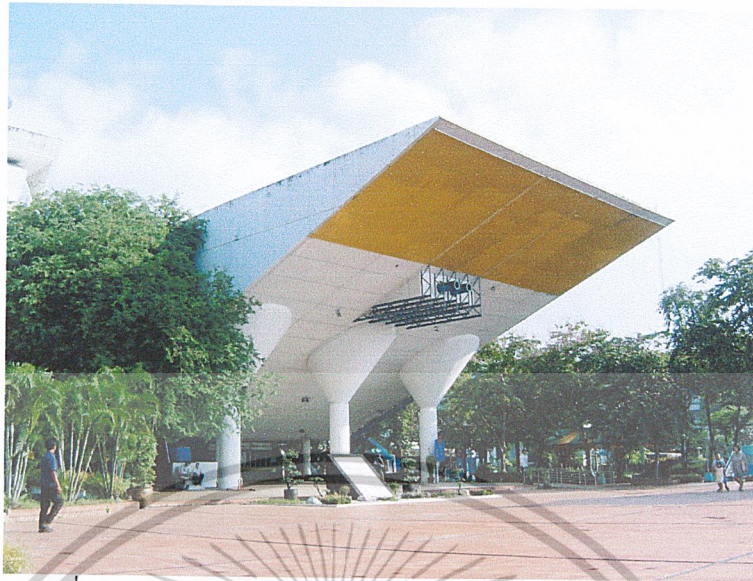
ภาพที่ 2.1.2.1 แสดงทัศนียภาพภายนอกของพิพิธภัณฑสถานวิทยา (ส่วนทางเข้าด้านหน้าของอาคาร มีส่วนที่เป็นห้องฉายภาพยนตร์ รูปสามเหลี่ยมยื่นยาวออกมาจากเสารองรับถึง 15 เมตร)
