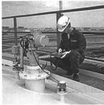
ภาพที่ 3.13 แสดงการติดตั้งเกจวัดระดับแบบลูกลอยและลูกลอยและ Mechanical Tape
