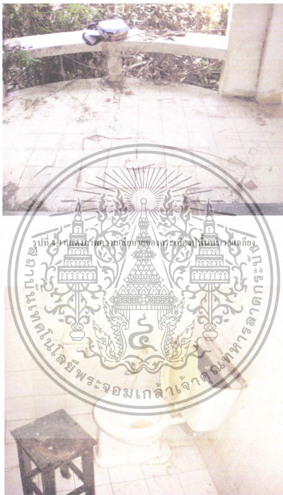
รูปที่ 4.5 แสดงภาพความเสียหายของสุขภัณฑ์ภายในห้องน้ำ
