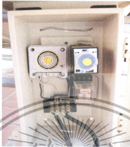
ภาพภาคผนวกที่ 6 แสดงลักษณะ Electrical time ที่ใช้ควบคุมเวลาการให้น้ำและปุ๋ย
