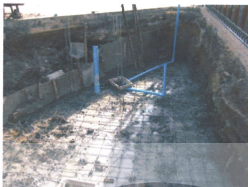
ภาพที่ 31 เดินท่อชักน้ำทิ้งมากบ่อพัก
