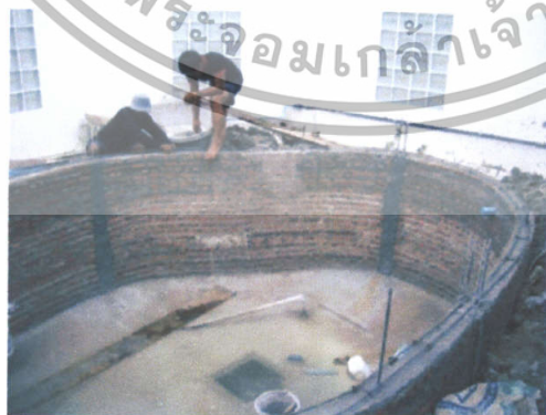
ภาพที่ 34 ผนังบ่อที่กำลังเตรียมเทพื้นหลัง
