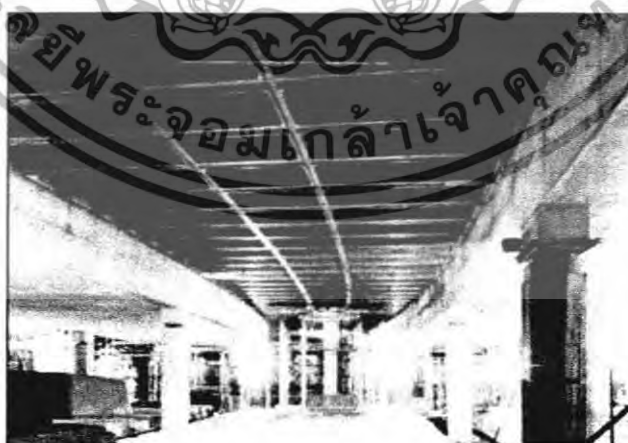
รูปที่ 4.23 รูปแสดงพื้น waffle slab รองรับพื้นที่ชั้นขานชาลา(platform)
