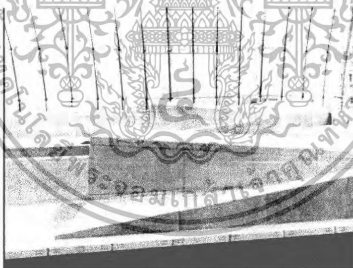
รูปที่ 4.26 รูปแสดงวัสดุพื้นผิวของตัวชั้น platform ที่ใช้ precast concrete เป็นวัสดุปิดผิว
