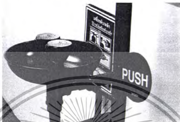
รูปที่ 3.1.1.31 ฝักบัวชำระถูกเงินสำหรับตาและหน้า (Eye/Face Wash)
