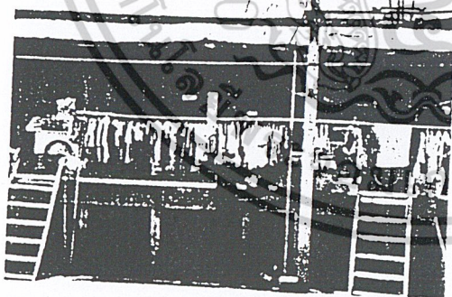
ภาพที่ 3-17 ราวตากผ้าแขวนกับ ท่อนเหล็กวางบนเสาปักในน้ำ
