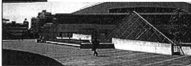
ภาพที่ 3.2.1.7 พื้น Plaza ชั้น2 มีการเจาะ ช่องแสง Skylight เพื่อให้ความสว่างแก่พื้นที่ ชั้นล่าง
