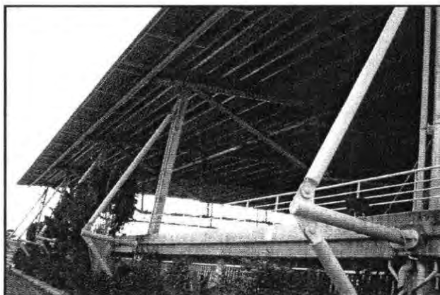
ภาพที่ 3.1.1.12 ลักษณะโครงสร้างสระที่ เป็น Concrete เปลือยกับโครงสร้างเหล็ก โดยที่คลุมด้วยสระ
