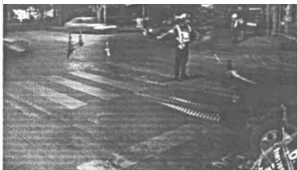
ภาพที่ 2-23 หลังจากปฏิบัติงานเสร็จสิ้นก็รีบเก็บกรวยยาง ป้ายสัญญาณและคืนที่
