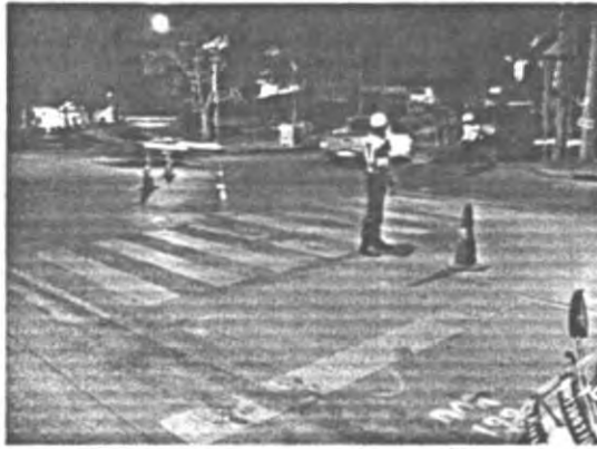
ภาพที่ 3-83 จัดวางแนวกรวยยางบนพื้นถนน
