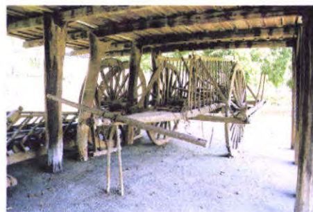
ภาพที่ 19 ใต้ถุนบ้าน แสดงให้ เห็นเสาซึ่งเป็นไม้ง่าม
