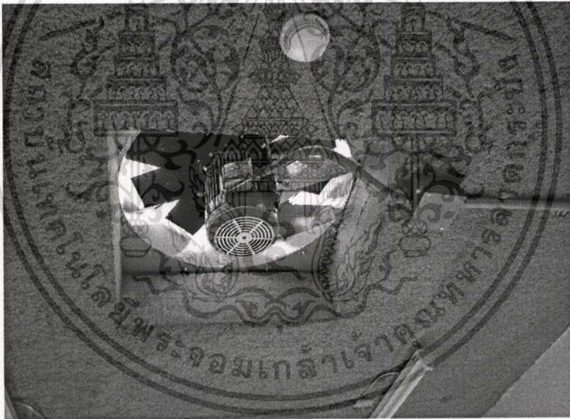
รูปที่ 2.13 พัดลมดูดควันไฟในกรณีเพลิงไหม้ซึ่งควบคุมโดย ระบบแจ้งเหตุเพลิงไหม้
