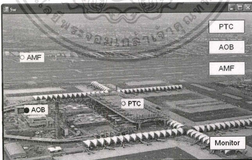
รูปที่ 6.9 หน้าจอแสดงการ Alarm ที่อาคาร AOB
