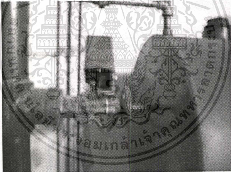
รูปที่ 2.11 Supper Visory เป็นอุปกรณ์ที่ไม่ให้ปิดวาล์วน้ำในระบบแจ้งเหตุเพลิงไหม้
