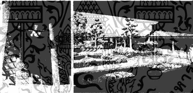
ภาพที่ 2.91 งานระบบปรับอากาศที่ใช้ในสนามบินจะเป็นพัดลมปรับอากาศและอากาศจากธรรมชาติมีการบ่อน้ำโดยรอบเพื่อให้มีลมความเย็นพัดเข้ามาในตัวอาคาร
