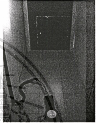
ลักษณะของแสงที่สะท้อนตัวสะท้อน แบบครึ่งวงกลมลงสู่บริเวณทางเดิน
