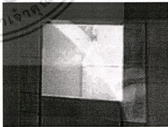
รูปที่ 3.22 ตัวสะท้อนแสงแบบแผ่นเรียบ และติดตั้งเอียง 45 องศา ณ บริเวณจุดจ่ายแสงของแต่ละชั้น
