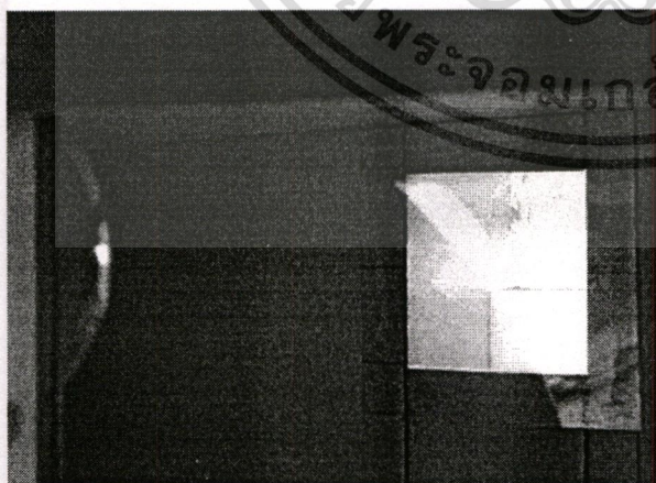
รูปที่ 3.22 ตัวสะท้อนแสงแบบแผ่นเรียบ และติดตั้งเอียง 45 องศา ณ บริเวณจุดจ่ายแสงของแต่ละชั้น
