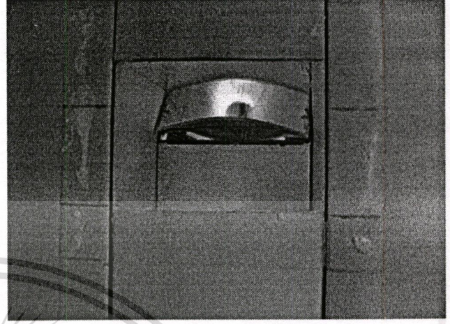
รูปที่ 3.23 ตัวสะท้อนแสงแบบแผ่นเรียบ แต่ตัดโค้งในแนวนอนและติดตั้ง 45 องศา
