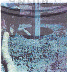
ภาพที่ 2.28 การเติมน้ำสารละลายเบนโทไนท์
