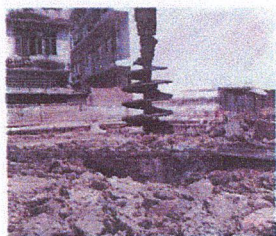
ภาพที่ 2.26 หัวเจาะดินแบบสว่าน
