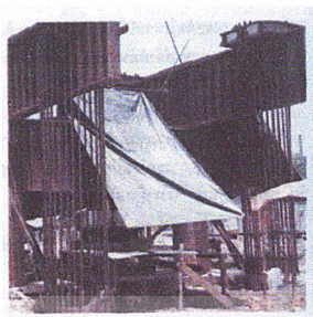
ภาพที่ 2.69 บริเวณเก็บอุปกรณ์การทดสอบเสาเข็มเจาะ
