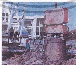
ภาพที่ 2.17 การกดและถอนปลอกเหล็กโดยใช้ไฮโดร แสมเมอร์
