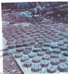
ภาพที่ 2.37 ลูกป้อนหมุนเหล็กเสาเข็มเจาะ
