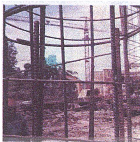
ภาพที่ 2.39 การต่อเหล็กเสริมเสาเข็ม
