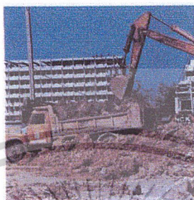
ภาพที่ 2.56 การขนดินออกจากพื้นที่เจาะเสาเข็ม
