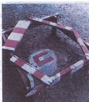
ภาพที่ 2.7 เสาเข็มเจาะที่เทคอนกรีตถึงระดับผิวดิน
