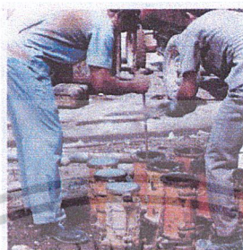
ภาพที่ 2.51 การเก็บตัวอย่างแท่งคอนกรีตที่ใช้หล่อเสาะเข็ม
