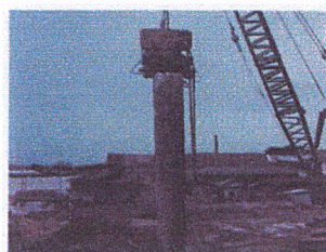
ภาพที่ 2.12 ปลอกเหล็กมีความยาว 15 เมตร ถูกยกปักลงไปในดิน
