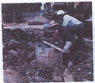
ภาพที่ 2.15 การตรวจจุดศูนย์กลางขอตําแหน่งเสาเข็ม
