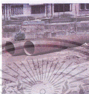
ภาพที่ 2.8 ปลอกเหล็กป้องกันดินพัง
