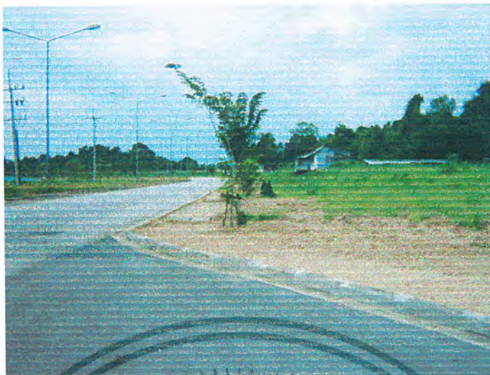
ภาพที่ 3.42 แสดงถนนภายในโครงการ
