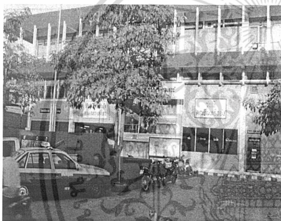
3. สถานีตำรวจพาลงกรณ์
