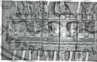
รูปที่ 4.6 แสดงภาพของชุดเบรกเกอร์ควบคุมชุดลดความร้อน
