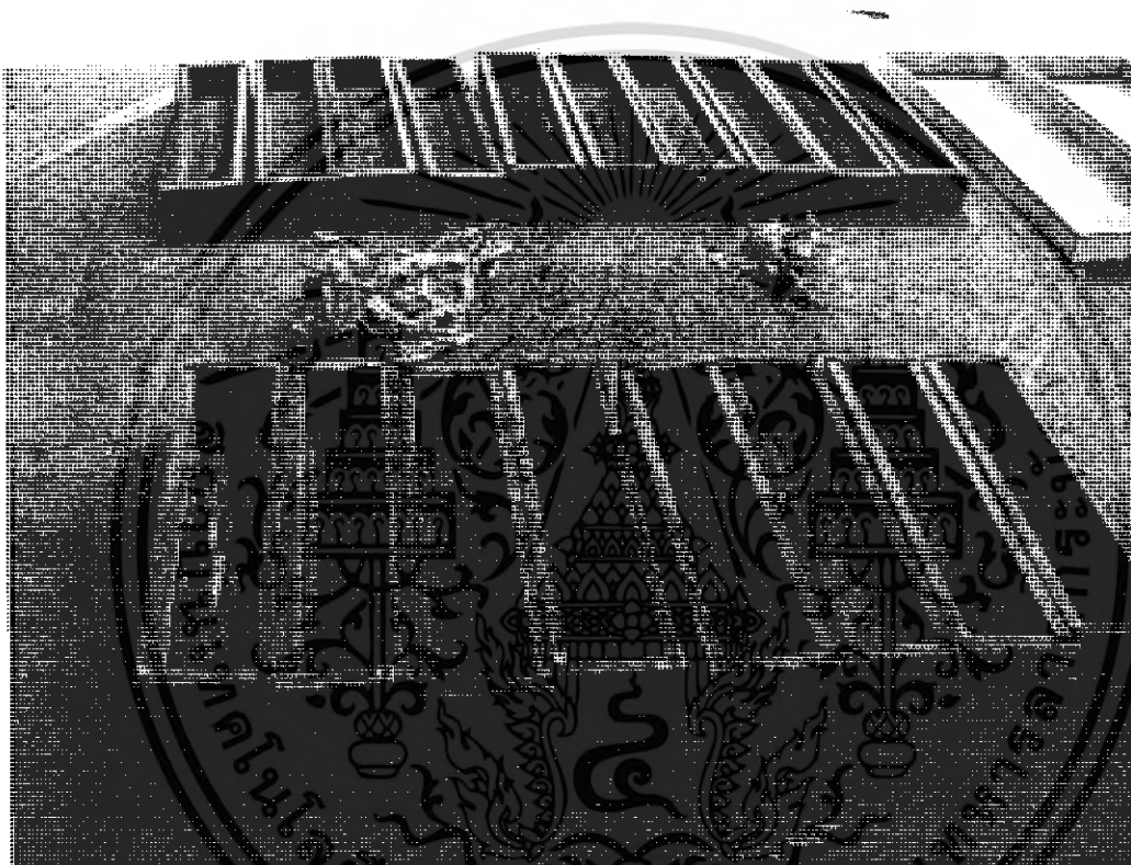
รูปที่ 3.11 แสดงภาพไม้แบบที่ทำการแช่น้ำแล้ว
