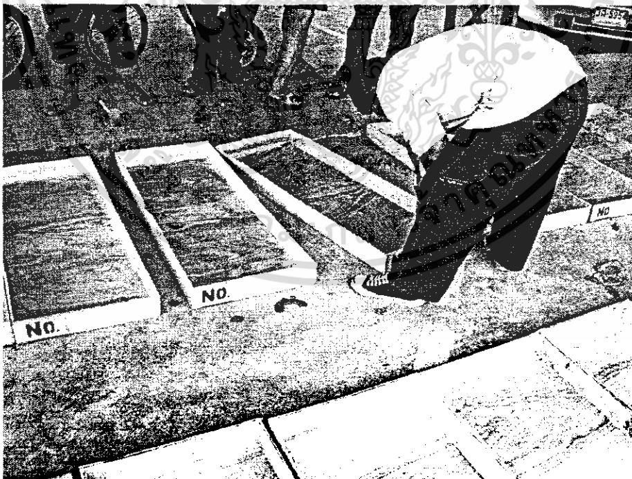
รูปที่ 3.18. แสดงการเตรียมแบบหล่อแผ่นพื้นคอนกรีต
