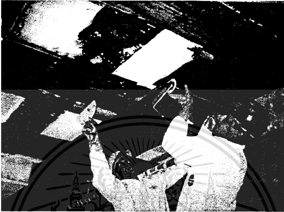
รูปที่ 2.9. แสดงลักษณะการนำเส้นใยคาร์บอน ไปใช้ในงานซ่อมพื้นที่ชำรุด
