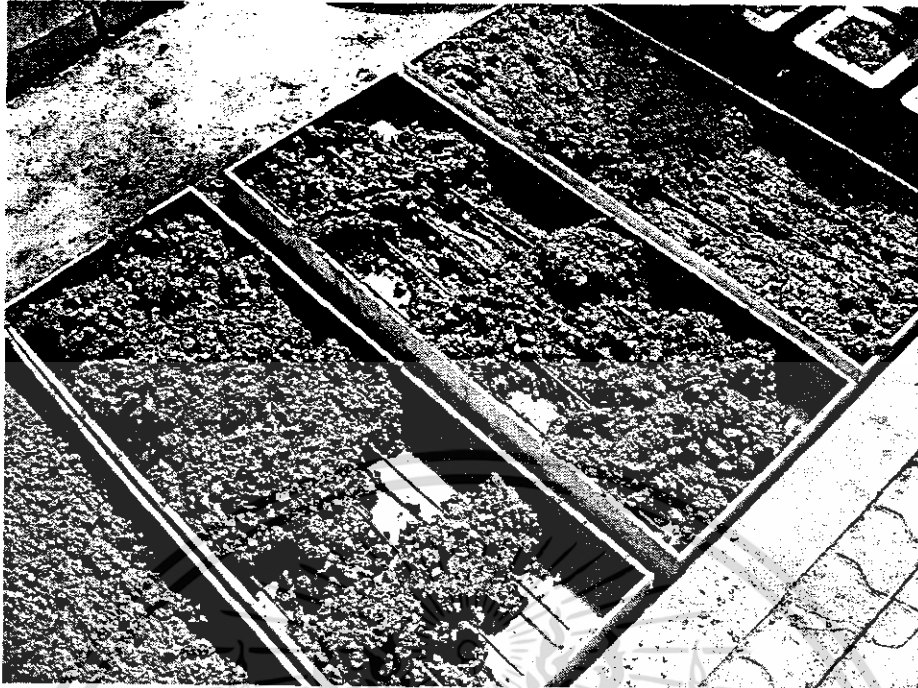
รูปที่ 3.20 แสดงการเทคอนกรีตแผ่นพื้นคอนกรีตเสริมเหล็ก
