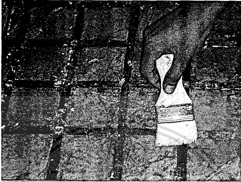
รูปที่ 3.28. แสดงการเสริมค้ำยเส้นใยคาร์บอนด้านนอกฉาบด้วยอิพอกซี
