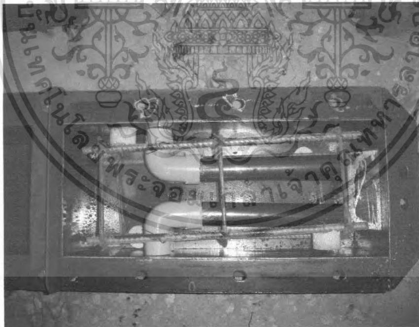
รูปที่ ผ.ง.14. แสดงแบบหล่อของเสาสำเร็จรูป
