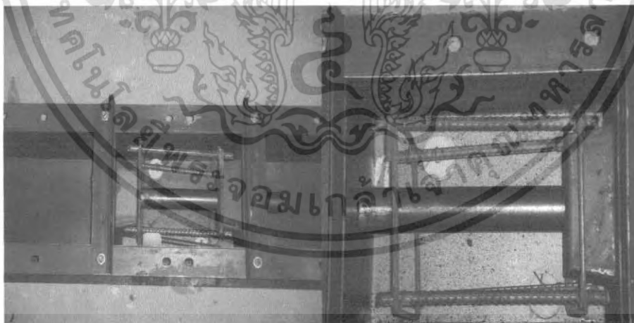
รูปที่ ผ.ง.20. แสดงแบบหล่อของคานสำเร็จรูป
