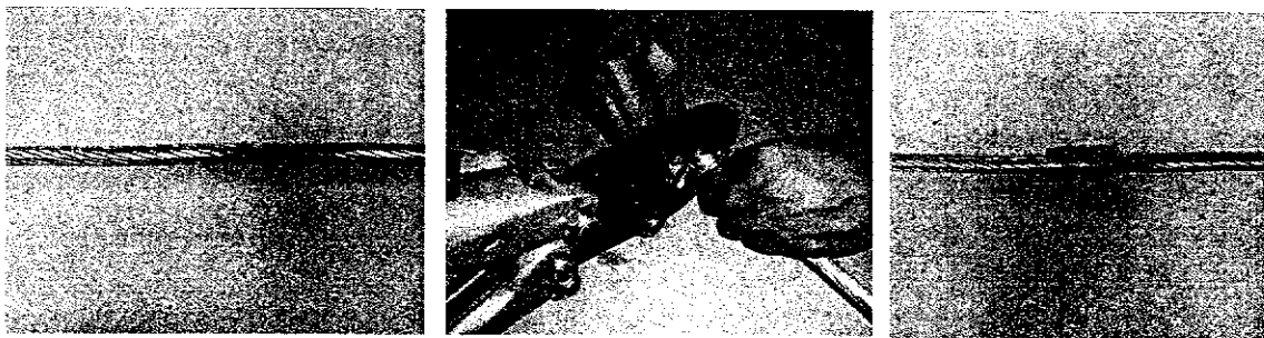
รูปที่ 3.29 การประกอบ Equalizer กับสายตัวนำ
