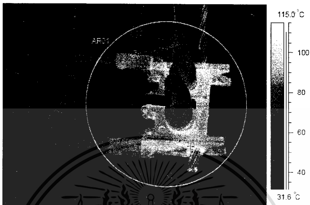
รูปที่ 3.82 อุณหภูมิที่เกิดขึ้นบน Hot Line Bail Clamp และ Hot Line Clamp ชุดที่ 4
