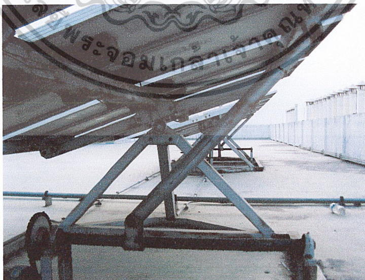
รูปที่ 2.4 กลไกที่ใช้ในการปรับมุมของชุดปรับมุมของแผงเซลล์แสงอาทิตย์
