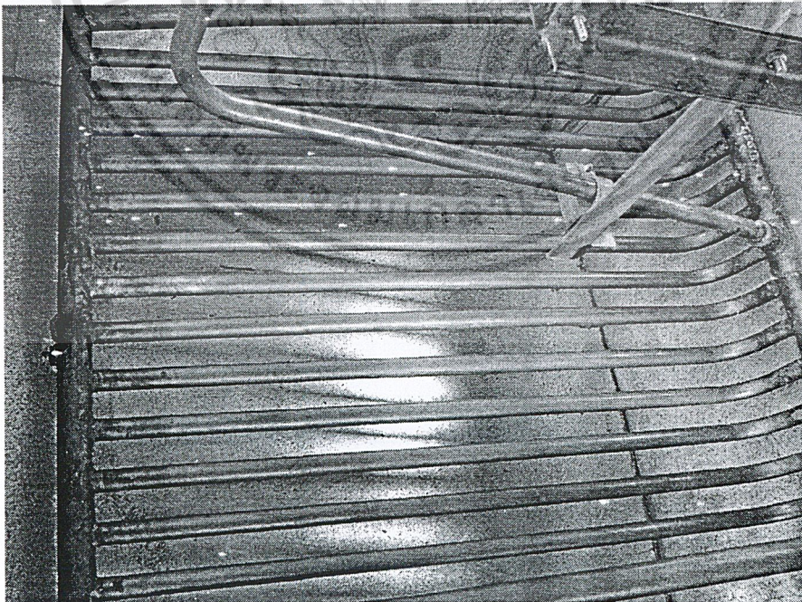
รูปที่ 4.3 โครงสร้างของเครื่องควบแน่น
