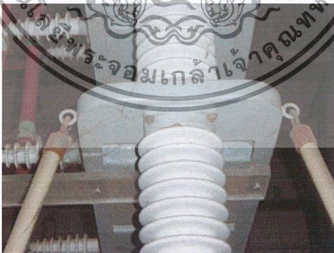
รูปที่ 3.24 การยึด Supportor กับโครงเหล็กเพื่อเป็นตัวตั้งทั้ง 4 มุม
