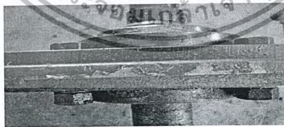
รูปที่ 3.4 แสดงการติดตั้งเบริง
