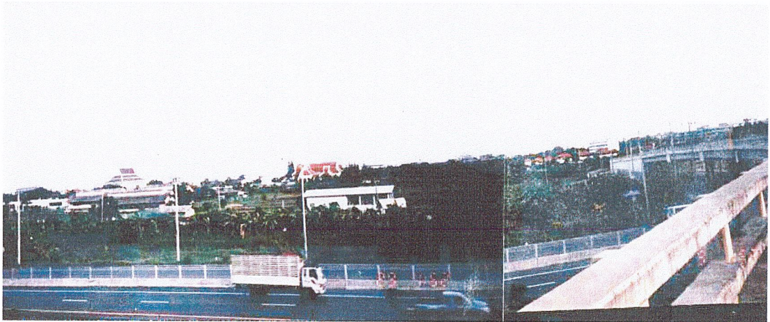
รูปที่ 2.5 แสดงที่ตั้งโครงการ site 3
