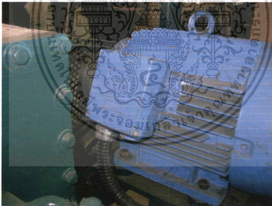
ภาพที่ ค 7 ตำแหน่งการวางมอเตอร์และสายไฟไม่มีความปลอดภัย
