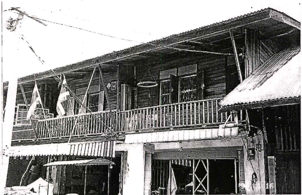
ภาพที่ 4.10 แสดงลักษณะอาคารไม้ผสมคอนกรีตแบบ 2 ชั้นในตลาดล่าง
