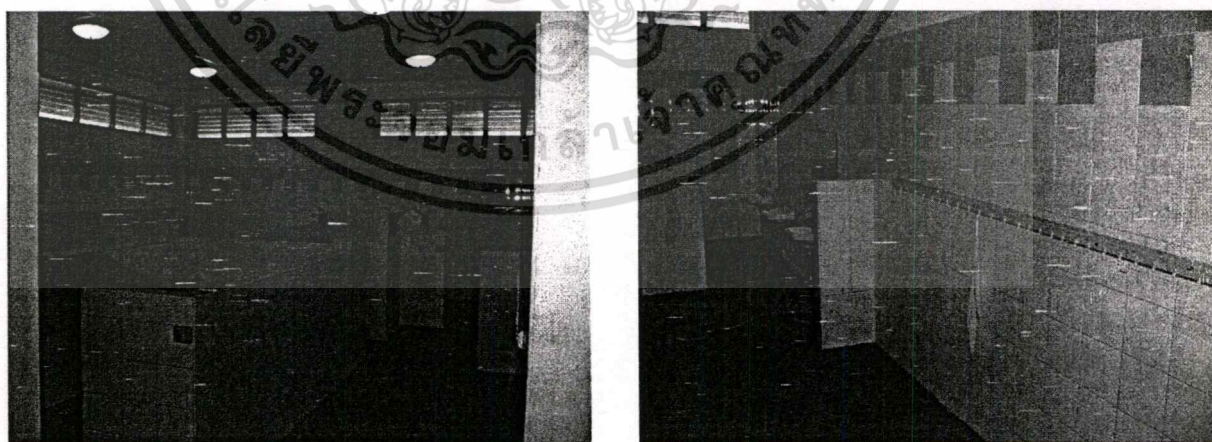
ภาพที่ 4.74 แสดงสภาพแวดล้อมภายในห้องน้ำ
