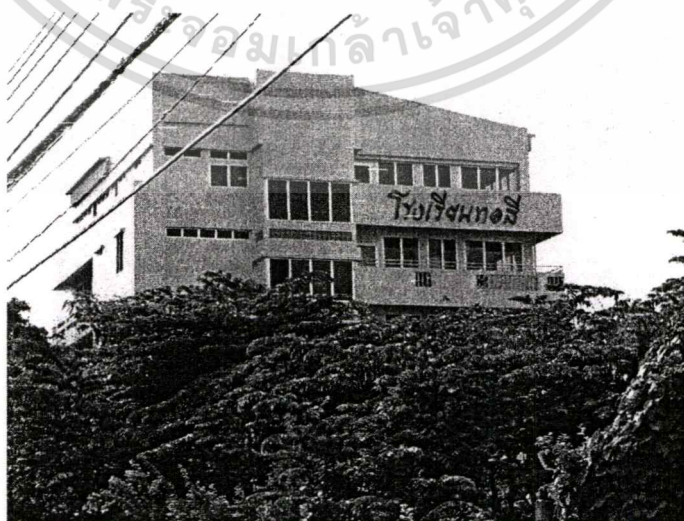
ภาพที่ 4.36 แสดงตัวอาคาร โรงเรียนอนุบาลทอสี จากมุมมองระยะไกล
