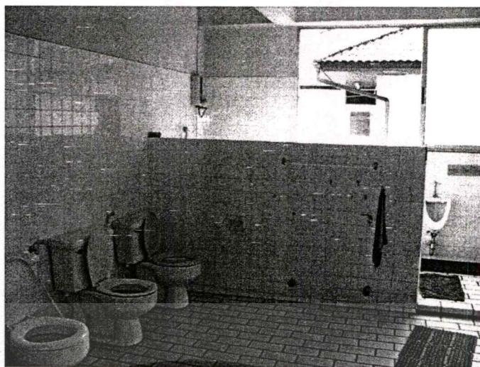
ภาพที่ 4.53 แสดงสภาพแวดล้อมภายในห้องน้ำ
