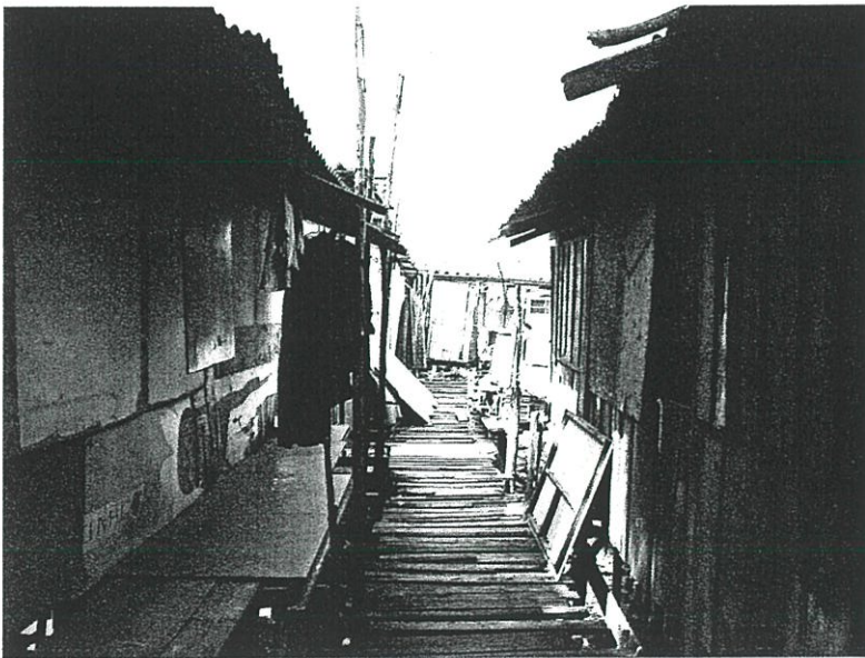
ภาพที่ 4.17 การใช้ไม้และเศษวัสดุเป็นวัสดุหลักในการสร้างที่อยู่อาศัย
