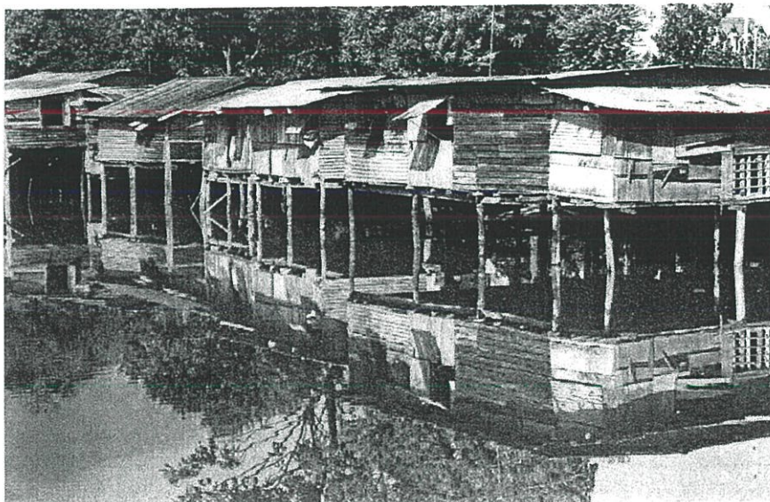
ภาพที่ 2.7 แสดงลักษณะบ้านพักอาศัยที่มีการปลูกสร้างบุกรุกเข้ามาในลำคลองสาธารณะ
