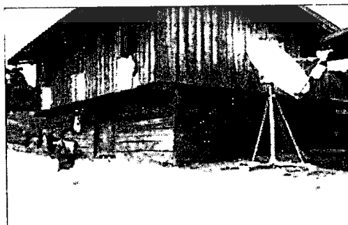
รูปที่ 2.6 การติดตั้งโทรศัพท์สาธารณะทางไกลชนบทโดยใช้ระบบดาวเทียมเป็นตัวสื่อสัญญาณ เอกสารนี้เป็นเอกสารที่สงวนไว้สำหรับการใช้งานเพื่อการศึกษาเท่านั้น ไม่อนุญาตให้นำไปใช้ประโยชน์ด้านการค้า ไม่ว่าจะกรณีใดๆทั้งสิ้น อีกทั้งห้ามมิให้ดัดแปลงเนื้อหา และต้องอ้างอิงถึงเจ้าของเอกสารทุกครั้งที่มีการนำไปใช้
