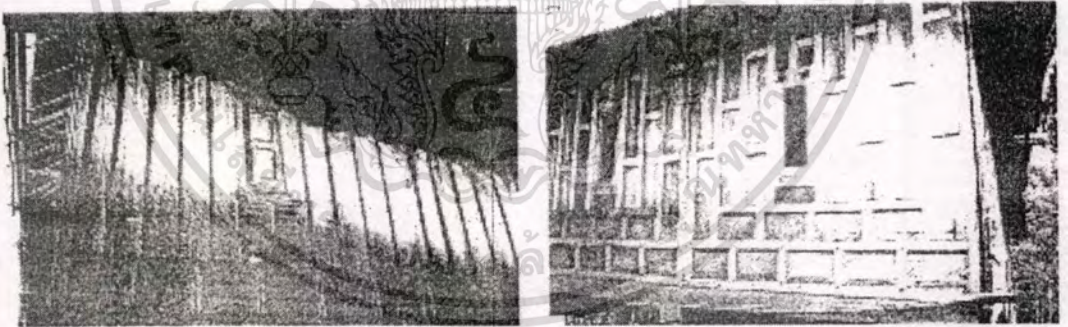
รูปที่ 2.37 ฝาเรือนไม้จริง ประเภท ฝาปะกน พบที่บ้านสระปทุมตำบลไชยชัย
